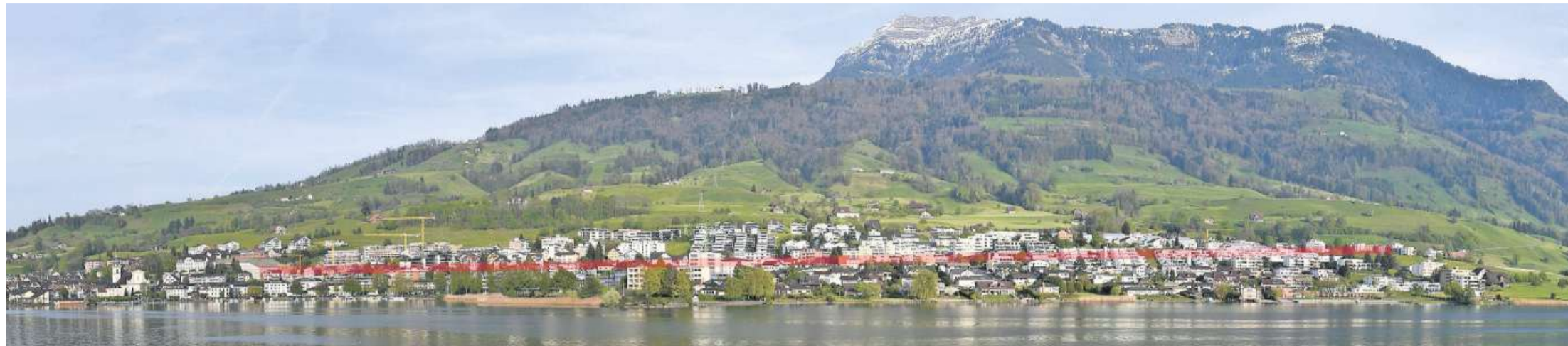
Auf dem Foto sieht man rot markiert die Länge des Abschnitts 2 der Südumfahrung von der Rämatt (links) bis ins Breitfeld. Mit dem Tunnel sollen die Quartiere entlang der Grepperstrasse entlastet werden.
